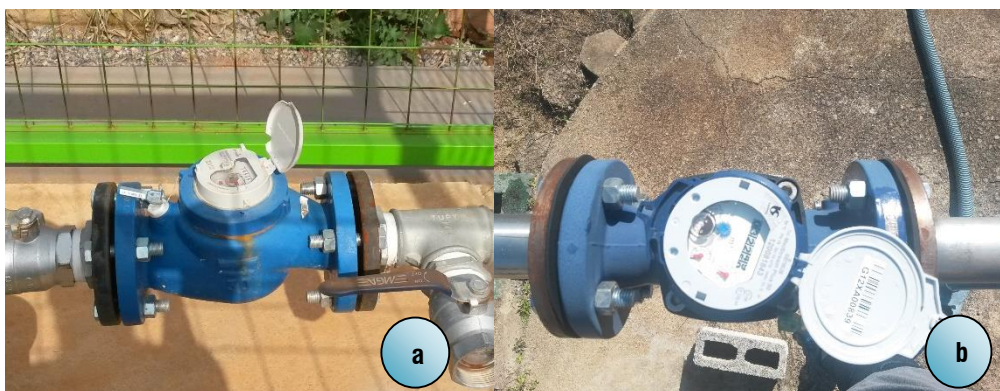
Figura 28 - ETA: a) Macromedidor Poço P4 – Passa Três b) Macromedidor Poço P1 - Tuiuti.
