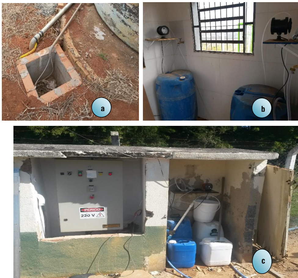
Figura 20 - ETA: a) Fluoretação e Cloração - Reservatório – Passa Três b) Sistema de dosagem Cloro e Flúor – Poço do Passa Três; c) Sistema de Tratamento de Água Poço P1 – Tuiuti.
